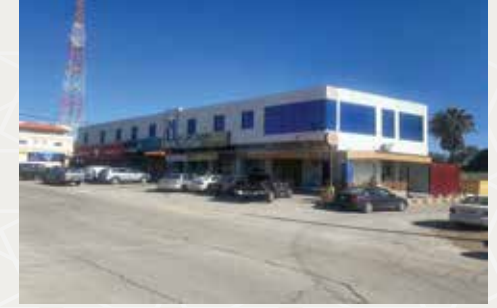
مشروع مخازن غرفة تجارة المزار الجنوبي – الكرك
