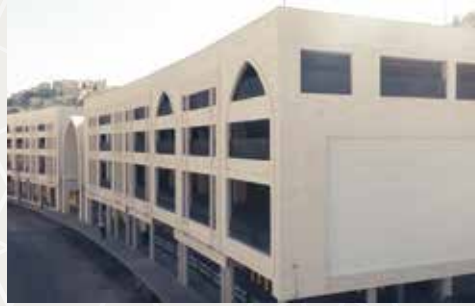
مشروع مخازن سقف السيل – عمان
